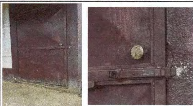
Foto 2: mantenimiento de estructura de puerta (lijado cambio de tubo, sujetaciones, aplicación de pintura sustrucción de chapas)
