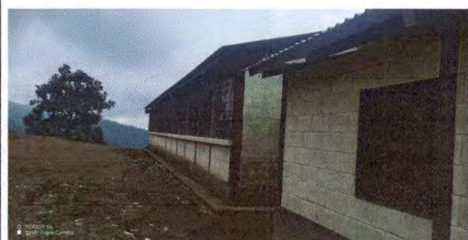
Foto7: Pintura en muros exteriores e interiores.
