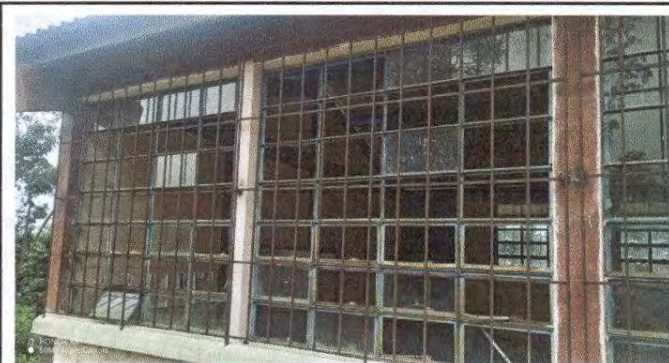
Foto 3: Mantenimiento estructura de metal de ventana, sustrucción de vidrios, mantenimiento a balcones de metal.
