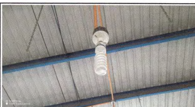
Foto 12: Sustitución de lamparas tipo LED.
