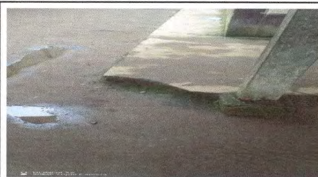
Foto 4: Reparación de piso de torta de concreto.
